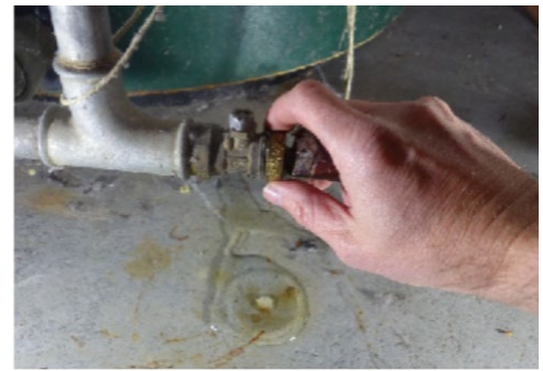
Abbildung 7: Heizung und Trinkwassernetz zum Nachfüllen verbinden
