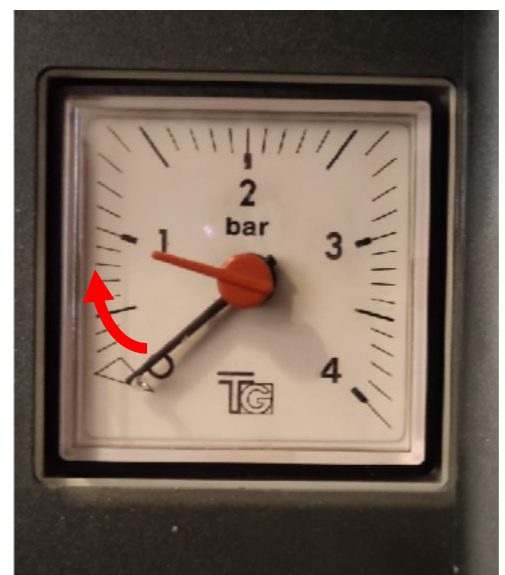
Abbildung 6: Druck kontrollieren und gegebenenfalls Heizungswasser nachfüllen.
