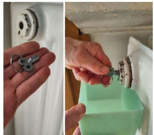
Abbildung 8: Heizkörper entlüften
