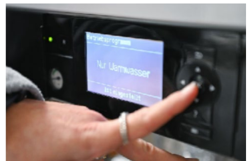
Abbildung 11: Sommerbetrieb einstellen: Nur Warmwasser
