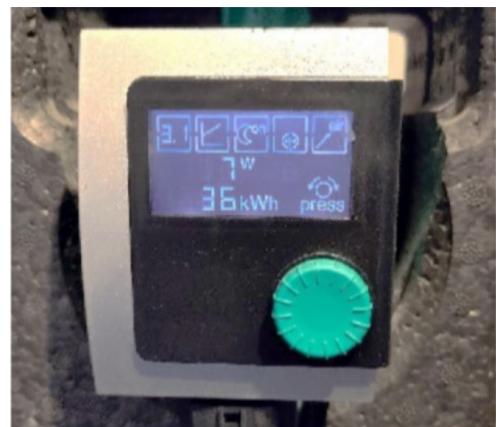
Abbildung 9: Nachgerüstete Hocheffizienzpumpe
